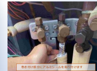
巻き付け部分にアルミシールを貼り付けます
