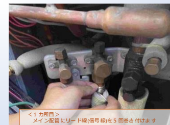
＜1カ所目＞ メイン配管にリード線(信号線)を5回巻き付けます
